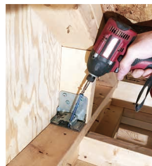
たて枠が右側の場合は金物刻印R側にビスを2本打ってください。
